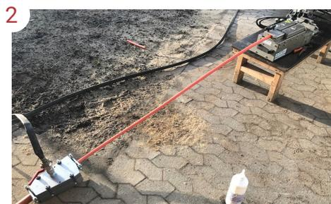
2 Les éponges sont le premier élément à souffler à travers le conduit. Cela nettoie le conduit installé et contrôle que les éponges arrivent à l'extrémité opposée du conduit. Après l'arrivée des éponges, le soufflage de fibres peut commencer. Commencez par appliquer une pression de 1 à 2 bars pour redresser la taupe de câble et le culot d'ancrage.
