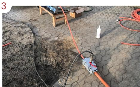
3 Environ 50 m après le début du processus de soufflage de fibres, le micro-câble rencontre un peu de résistance qui fait osciller le câble. Pour éviter cela, l'alimentation en air du bloc Y a été augmentée. Cela détend le câble, qui arrête d'osciller. Après 150 m, l'air et la vitesse sont progressivement augmentés, jusqu'à ce que le plein air soit atteint. Dans ce cas, le câble est soufflé jusqu'au bout du conduit sans résistance majeure.
